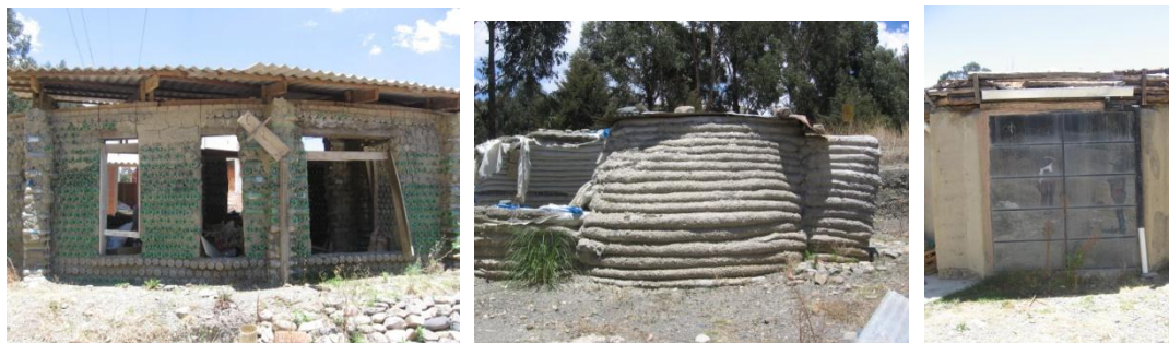
Foto 35. Ejemplos de ecoconstrucción en la UMSA, sede Cota-Cota, de izquierda a derecho: Casa de botellas pet, casa de superadobe y muro trombé
